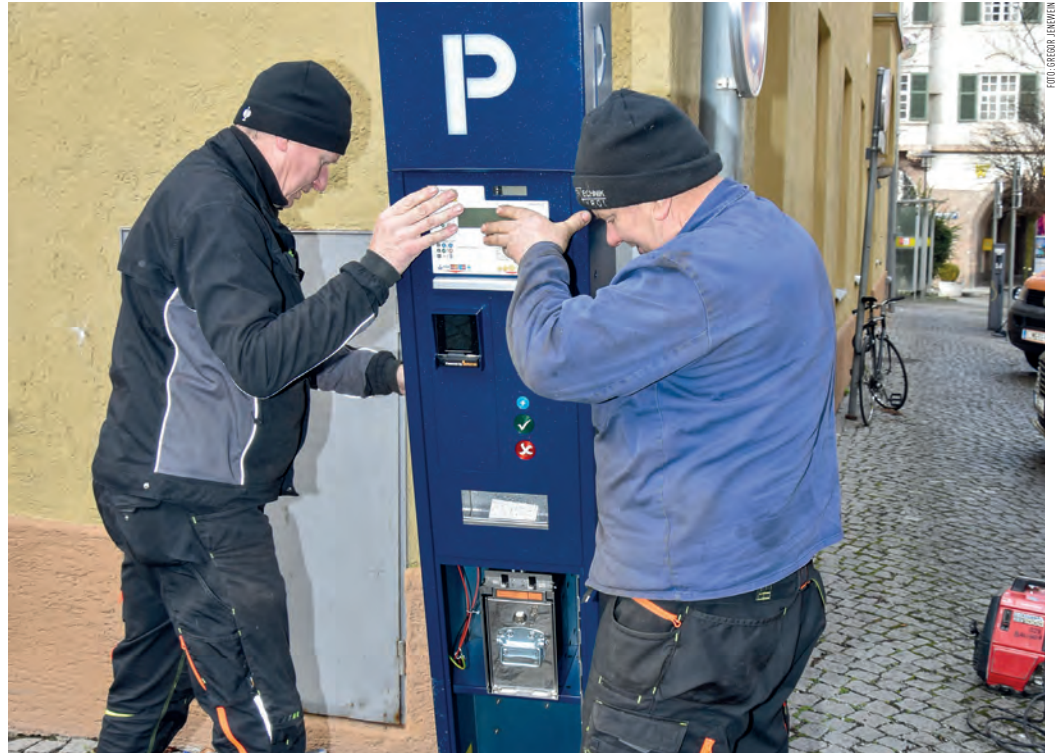
Die Monteure des Bauhofs beim Installieren des neuen Parkautomaten in der Krippgasse beim Haus am Marktanger.
